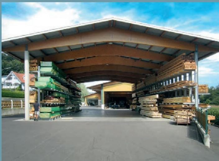
Système de rayonnages à structure ouverte avec deux étagères double face galvanisées à bras portants. Structure moderne de toit en bâtière avec couverture en tôle bac acier. Grande dalle de fondation.
