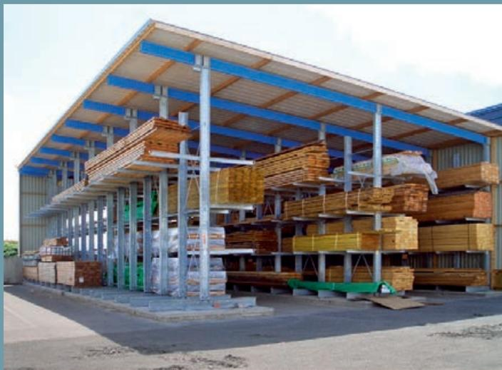
Système de rayonnages semi-fermé à bras portants avec étagères galvanisées à chaud. Toiture et cloison en tôle bac acier. Agencement réussi d'une construction annexe à une structure existante.
