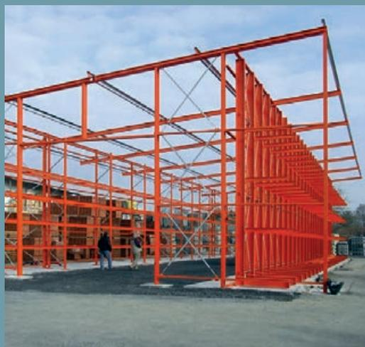
Structure composée à la fois de rayonnages à palettes et rayonnages à bras portants. Sous-structure avec mur de pignon, juste avant le bardage. Calcul des données statiques du bloc de fondation et des semelles de fondation.
