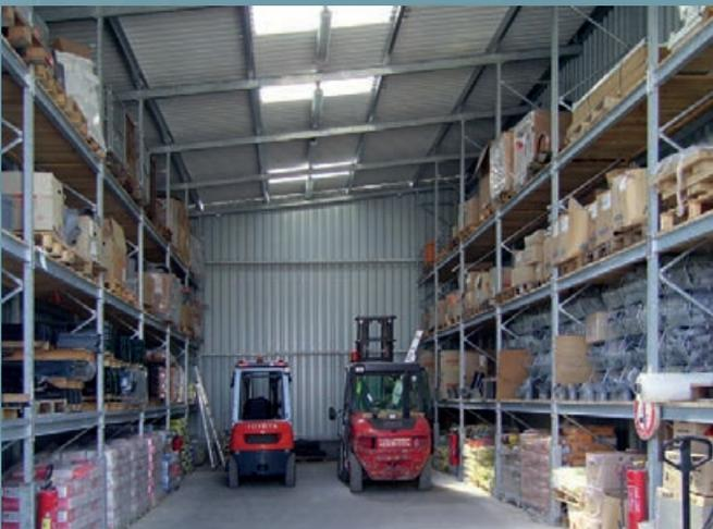
Hall de rayonnages à palettes chez un négociant en matériaux de construction. Toiture et cloison réalisées entièrement en tôle bac acier. Avec portail coulissant et fenêtres-coupoles pour la diffusion de lumière naturelle. Protection supplémentaire des cadres d'étagères contre les forces d'impact.
