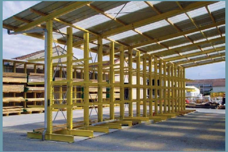
Système de rayonnages ouverts à bras portants dans la filière bois. Système complet avec toiture en tôle bac acier avec panneaux d'éclairage naturel, gouttière et tuyaux de descente. Bloc de fondation avec cale de compensation.
