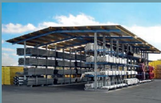
**Hall autoportant – construction ouverte** : du système de rayonnages traditionnels couverts à l'ensemble de rayonnages à structure ouverte. Construction complète avec toiture et bardage partiel.
