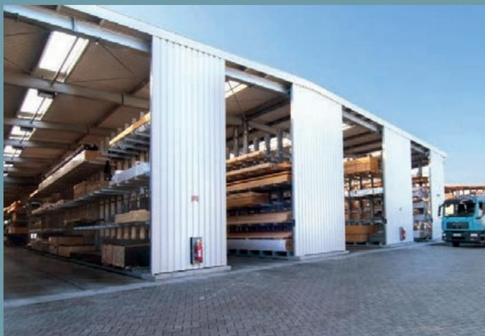
Entrepôt pour stockage de bois avec bardage toit et cloison. Rayonnages à bras portants entièrement galvanisés, avec rails de guidage pour entrepôts à allées étroites. Panneaux transparents dans chaque allée pour diffusion de la lumière naturelle.
