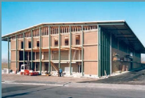
**Hall autoportant – construction fermée** : couverture de toiture et bardage compris dans la prestation. La construction de portails, de portes pour issue de secours et l'intégration d'un système de drainage font du hall autoportant une solution de stockage complète.
