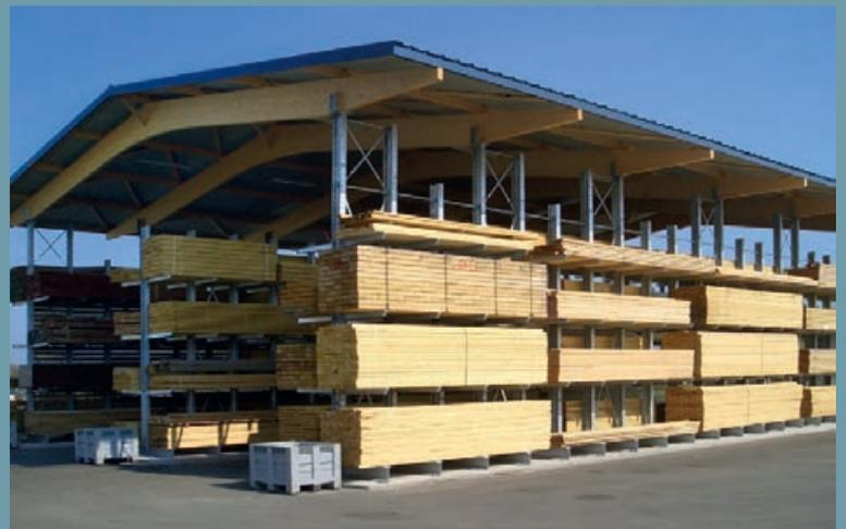
Système de rayonnages à structure ouverte avec trois étagères double face galvanisées à bras portants. Structure moderne de toit en bâtière avec 10 m de portée.
