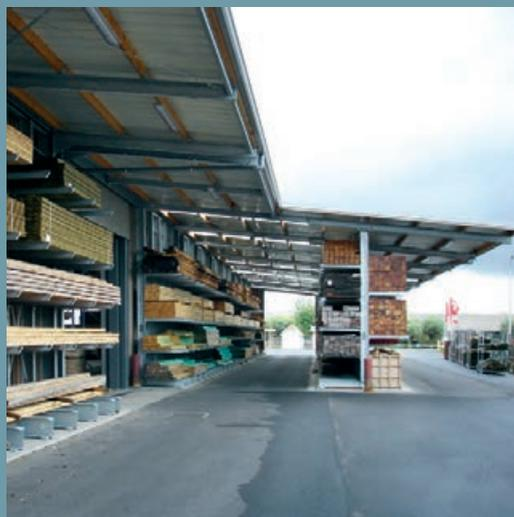
Hall de rayonnage complètement fermé avec une construction annexe supplémentaire ouverte, constituée d'une colonne de rayonnages à bras portants double face. Avec éclairage et panneau d'éclairage naturel au-dessus de l'allée de passage.
